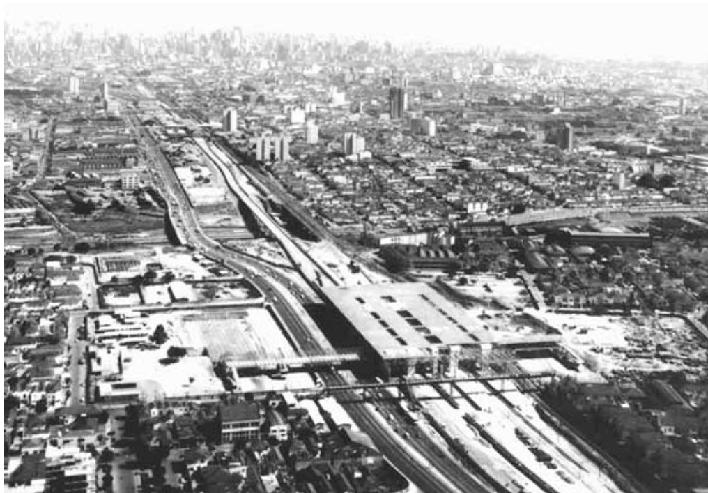
Figura 1.12: Construção da estação Tatuapé do metrô. Fonte Gazeta do Tatuapé, 1981.
